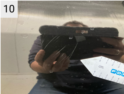
10 Sted H. fordør Del Dør Type Rust plet
